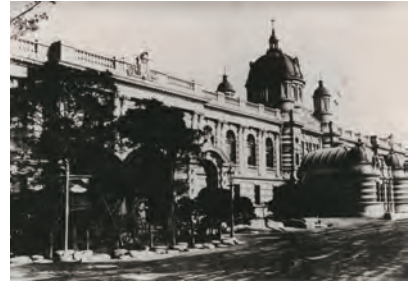
【図2】「通信省庁舎正面」1910年6月竣工（ACA-0035）
