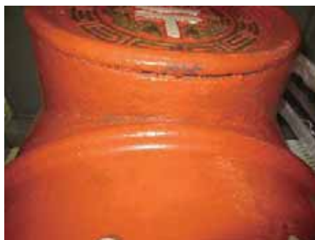
差入口下部（水抜きの穴がない）
