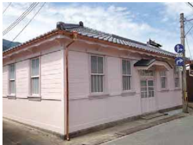
図5 再生直後の局舎
