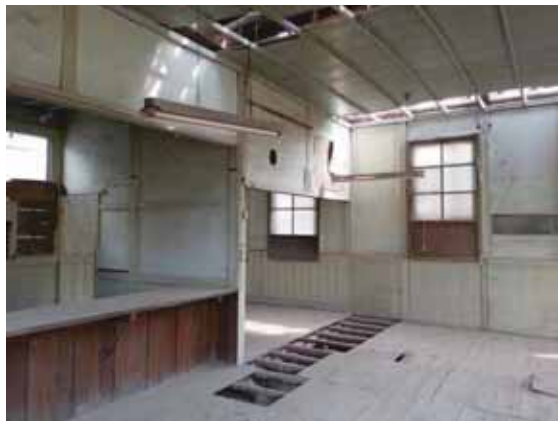
図6 再生前局舎内装
