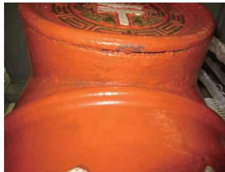
差入口下部 (水抜き穴がない)
