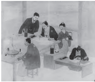
第25図 「明治二年始めて横浜東京間に電気通信を開く本図は横浜裁判所構内に設けたる伝信機役所にして最初の電信局なり」 (野生司香雪)
