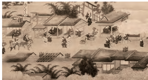
【図29】 八幡門前の町家 3棟にうだつが載る
