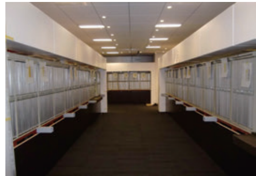
【図14】内装施工前の9階展示場【図15、16】施行中の33万種類の切手展示コーナー。大手町から1グリット500kgの引出し型の切手ケースを移動させ、荷重分散のための下地材を製作の上再設置したもの。(2013年、(株)丹青社「郵政博物館施工図」内、造作資料より抜粋)
