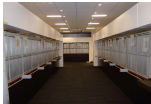
【図14】内装施工前の9階展示場【図15、16】施行中の33万種類の切手展示コーナー。大手町から1グリッド500kgの引出し型の切手ケースを移動させ、荷重分散のための下地材を製作の上再設置したもの。(2013年、(株)丹青社「郵政博物館施工図」内、造作資料より抜粋)
