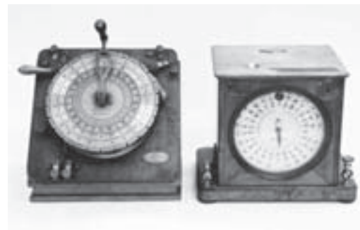
図9 ブレゲ指字電信機
