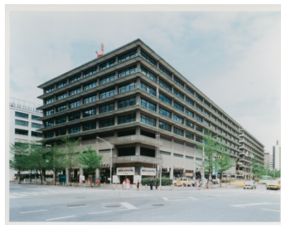
逡信ビル外観
